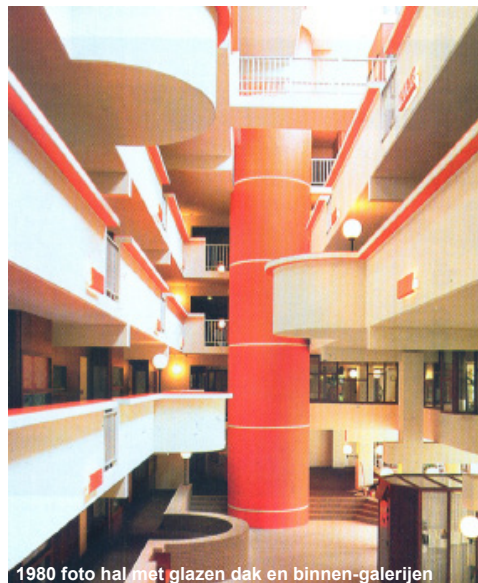
1980 foto hal met glazen dak en binnen-galerijen
