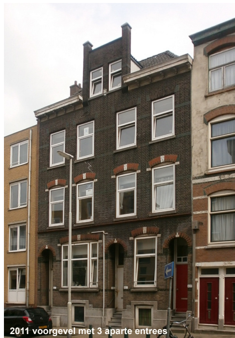
2011 voorgevel met 3 aparte entrees
