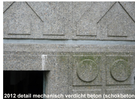
2012 detail mechanisch verdicht beton (schokbeton)
