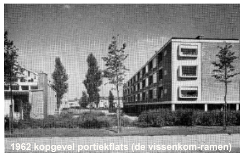
1962 kopgevel portiekflats (de vissenkom-ramen)
