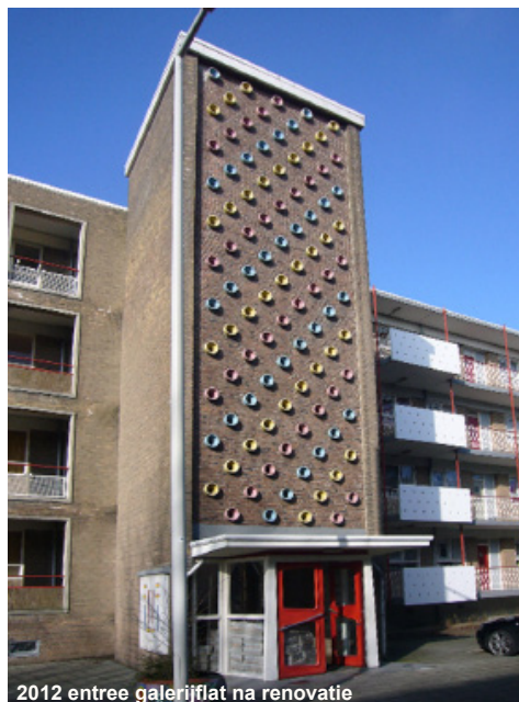
2012 entree galerijflat na renovatie
