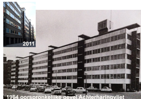
1964 oorspronkelijke gevel Achterharingvliet
