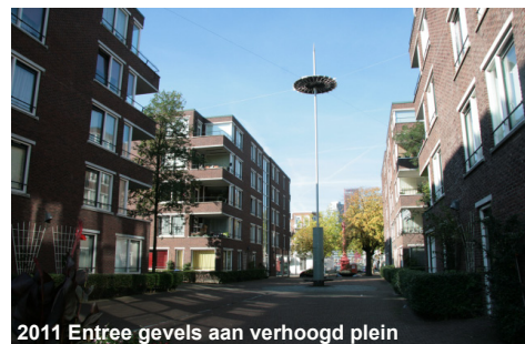
2011 Entree gevels aan verhoogd plein
