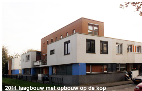
2011 laagbouw met opbouw op de kop
