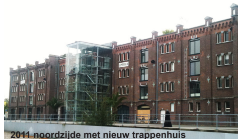
2011 noordzijde met nieuw trappenhuis
