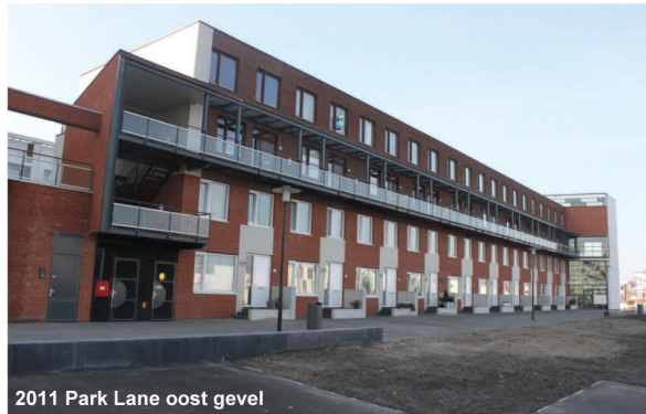
2011 Park Lane oost gevel
