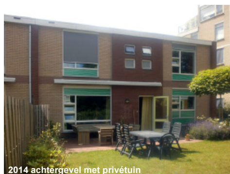
2014 achtergevel met privétuin
