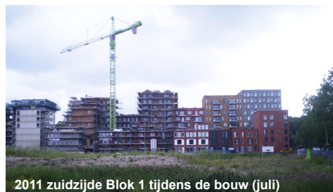
2011 zuidzijde Blok 1 tijdens de bouw (juli)
