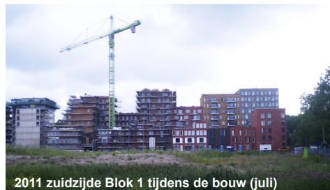
2011 zuidzijde Blok 1 tijdens de bouw (juli)
