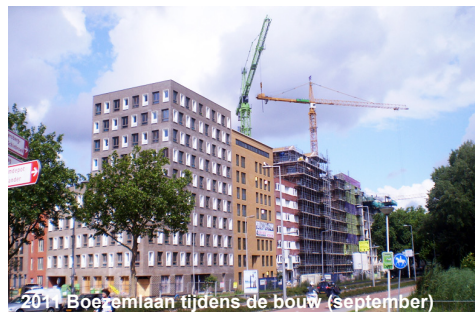
2011 Boezemlaan tijdens de bouw (september)
