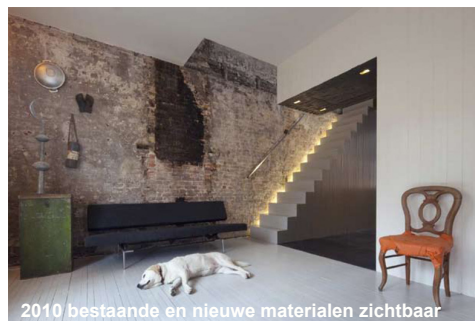
2010 bestaande en nieuwe materialen zichtbaar
