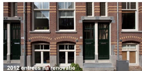
2012 entrees na renovatie
